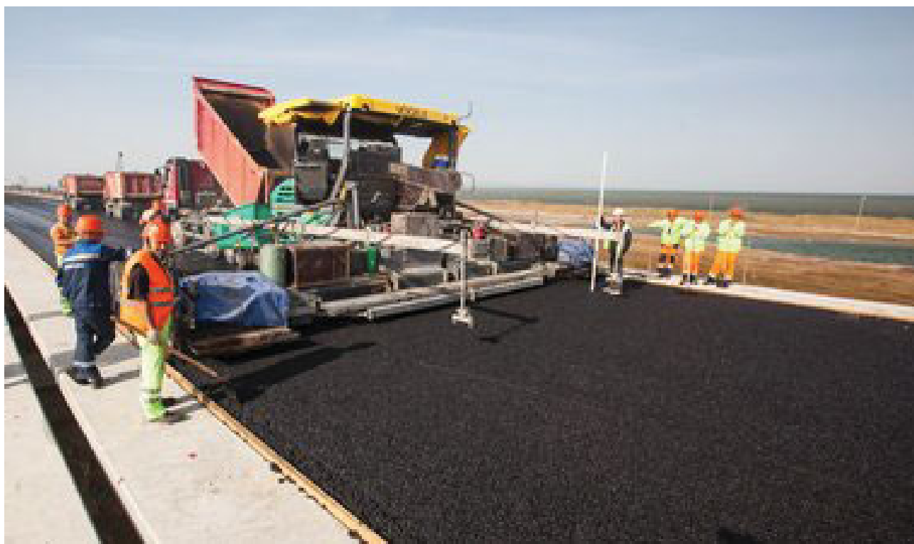
Строители уложили верхний слой асфальтобетона на пилотном участке Крымского моста на острове Тузла.
