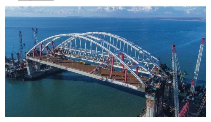
Автодорожная арка Крымского моста поднята на фарватерные опоры и надёжно закреплена на проектной высоте – 35 метров от воды. В полдень судоходство в Керчь-Еникальском канале возобновлено в обычном режиме – на 18 часов раньше запланированного срока.
