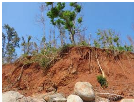
广东雷州市赤坎村海岸岩石大量剥落植物根茎裸露
