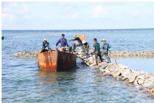
Các chiến sĩ đang đắp đá xây kè mở rộng đảo Sơn Ca. Ảnh: Lê Sơn
