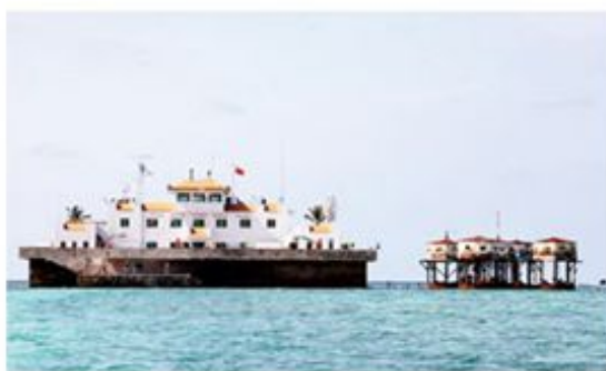
第三代高脚屋(礁堡)。右侧是第二代高脚屋遗迹。
